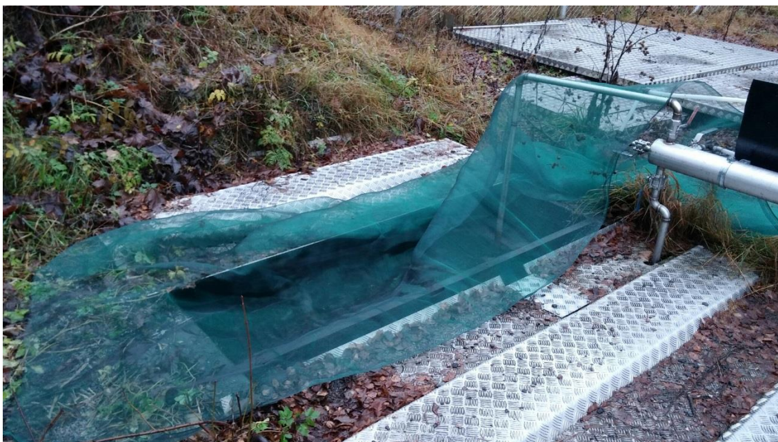
Kuva 22. Volskodin pienpuhdistamon ilmastusaltaan avattu osa peitettynä verkkokatteella.
