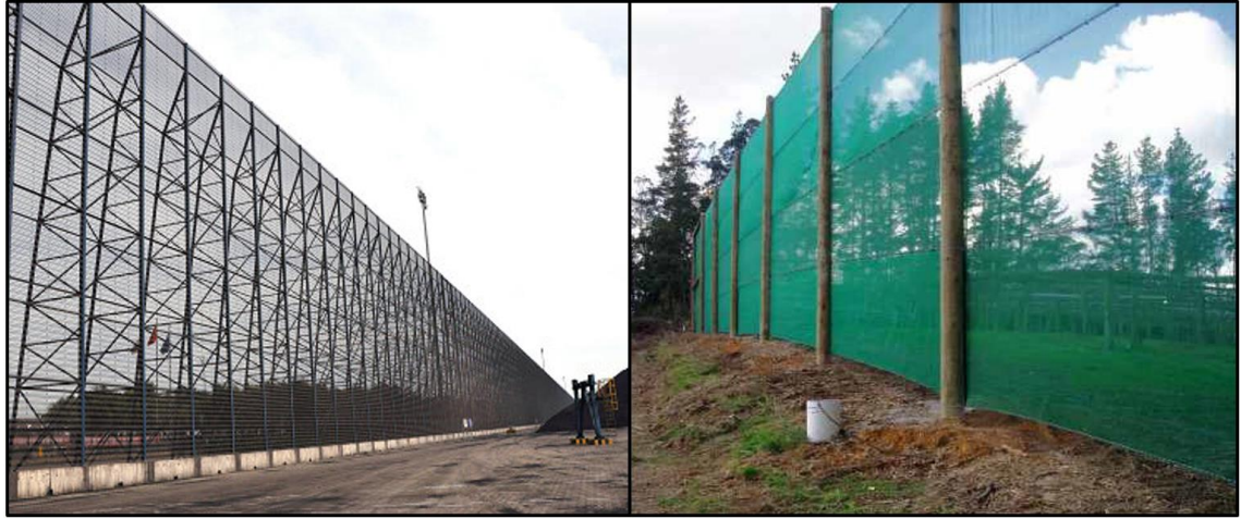
Kuva 10. Metallinen tuulensuoja-aita hiiliteollisuudessa ja muovinen tuulensuojaverkkoaita maataloudessa (AWD Windbreak panels company 2015, Cosio industries 2015).
