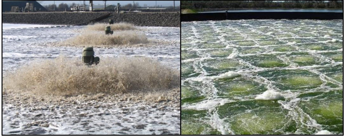
Kuva 4. Pintailmastimet (vasemmalla, turbiinipintailmastin) tuottavat silminnähdn enemmän pisanan muodostusta ja roiskeita kuin pohjailmastimet (oikella, hienokuplailmastin) (Aqua-Aerobic Systems 2015, Ashbrook Simon-Hartley 2015).
