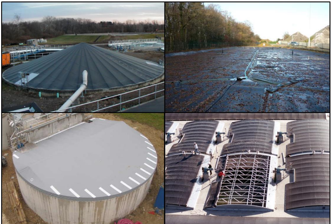
Kuva 7. Erilaisia muovimateriaaleista tehtyjä kateratkaisuja jätevesialtaissa. (Enviro-netics 2015 vas. yllä, Ciffa Systemes 2015 oik. yllä ja vas. alla, GTI covers 2015 oik. alla)
