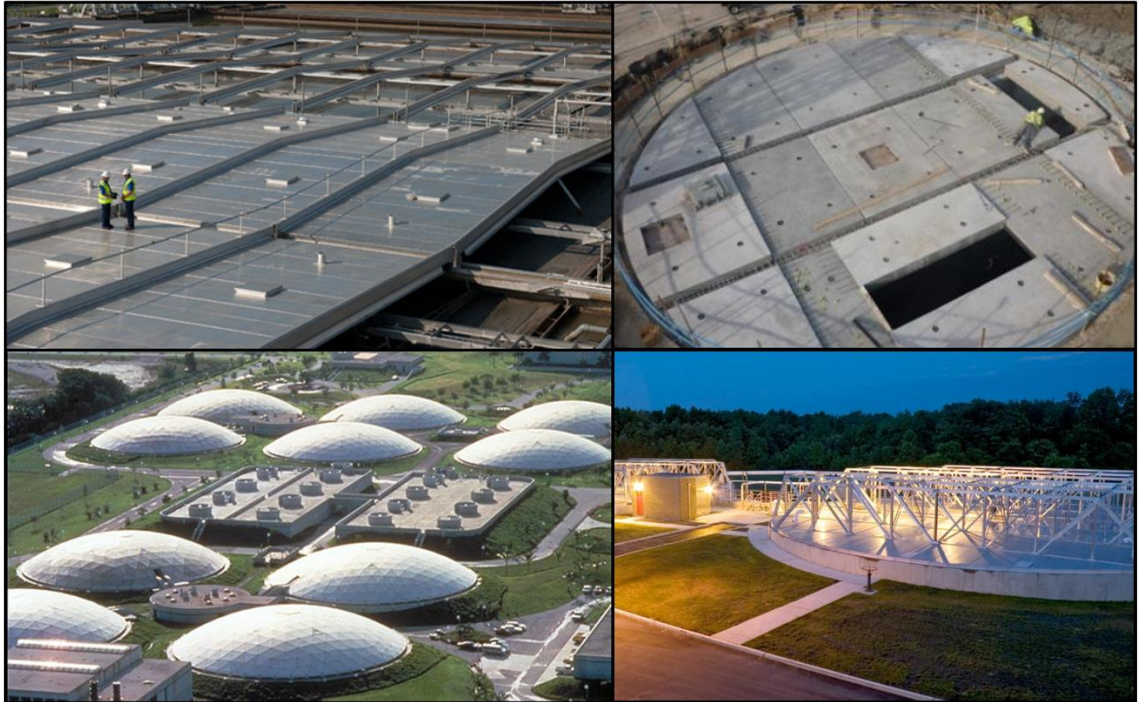
Kuva 6. Alumiinista (CST Industries 2015) sekä betonista (FP McCann Ltd. 2015 oik. yllä) valmistettuja katteita jätevesialtaissa.
