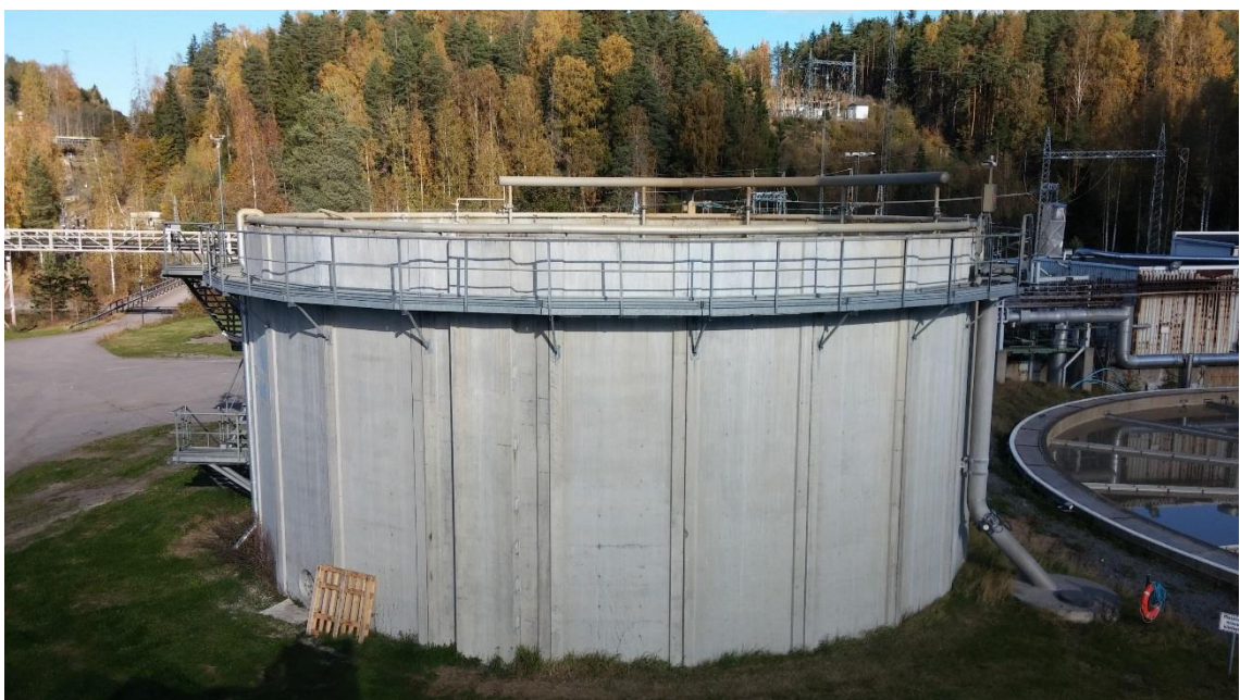
Kuva 17. Metsä Board Kyrön kantoaineallas, kuvassa näkyy sääaseman mittarit asennettuna 8.10. tangon päähän kävelysillalla vasemmassa reunassa.
