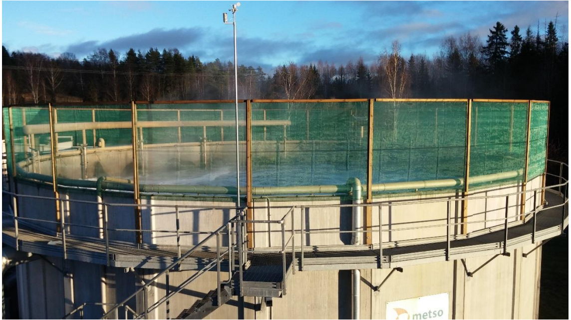
Kuva 20. Tuulensuojaverkko asennettuna Kyröllä bioreaktorin reunalle.
