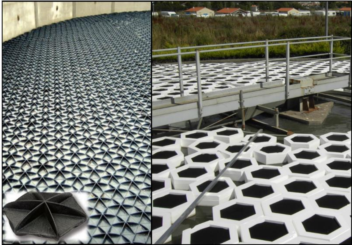
Kuva 3. Jätevedenkäsittelyn altaissa käytettyjä kelluvia kappaleita mm. hajuhaittojen ehkäisemiseksi (Lemna Technologies 2015a, Pi 2 Technologies 2015).
