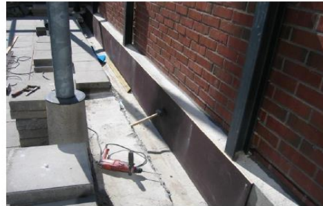
Kuva 4 Vesivanerista on tehty uusi seinällenoston alusta. Nyt kannella oleva vesi ei enää pääse vuotamaan vettä tiilimuurukseen.
