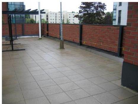
Kuva 7 Valmis korjattu kansi odottaa enää suojapellityksiä. Pihakivet on kavennettu ja asennettu takaisin. Vesitestin mukaan korjaus on onnistunut. Eikä enää tarvita kittejä.
