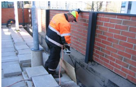
Kuva 5 Kermieristys on käynnissä. Vesieristeen toimivuus Varmistetaan vielä kuumabitumisivelyllä.
