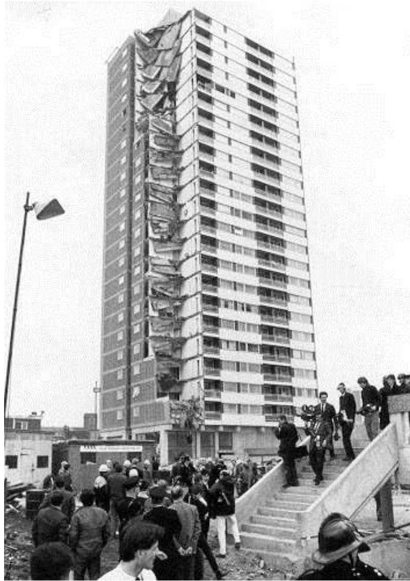
Kuva 7. Jatkuva sortuma Ronan Point kerrostalossa (Kuva:www.designingbuildings.co.uk)
