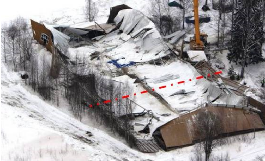
Kuva 4. Laukaassa sortunut ratsastusmaneesi. Rakennuksen kantavat teräskehät kaatuivat pistekatkoviivalla merkittyä linjaa kohti. (Onnettomuustutkintakeskus 2013)
