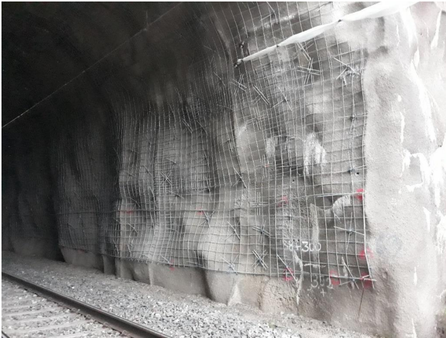
Kuva 27. Aiemmin ruiskubetonoidun pinnan päälle asennettiin verkko ja ruiskutettiin uusi ruiskubetonikerros.
