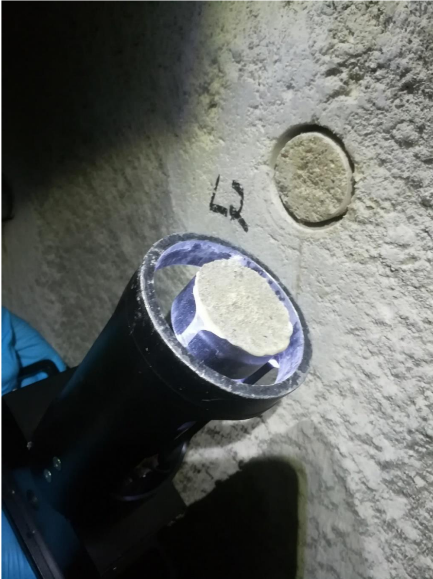
Kuva 30. Alueen 2 näytteen L2 vetokoe. Ruiskubetonilieriön pinta on antanut periksi ja teräslevyn pinnassa on näkyvissä ruiskubetonista irronnut osuus. Kuvassa on näkyvissä osittain myös HZP-ConsurTest vetolaite, jolla teräslevyä vedettiin.
