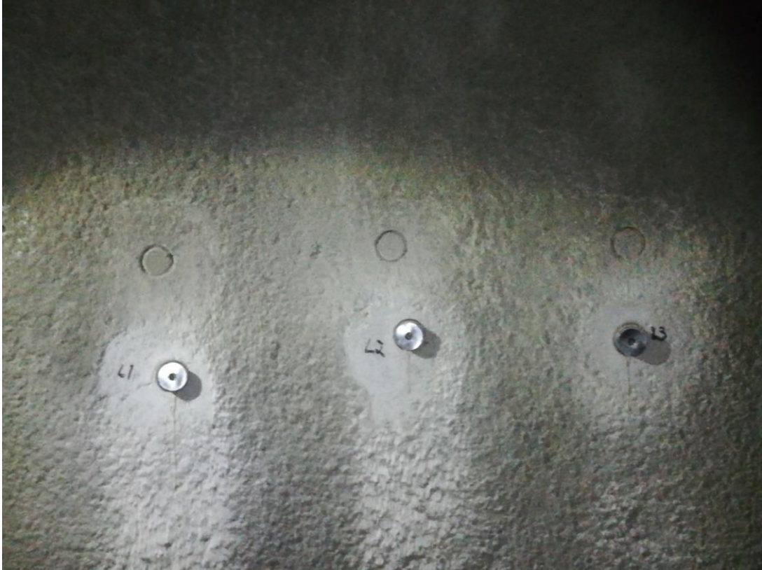
Kuva 29. Tartuntalujuusmittaus 28 vuorokauden kuluttua ruiskutuksesta alueella 2. Kuvassa on ruiskubetoniin porattuihin ympyrälieriöihin liimatut teräslevyt eli näytteet L1, L2 ja L3. Näytteiden yläpuolella näkyy 28 vuorokautta aiemmin suoritettujen tartuntalujuusmittausten jättämiä lieriöitä.
