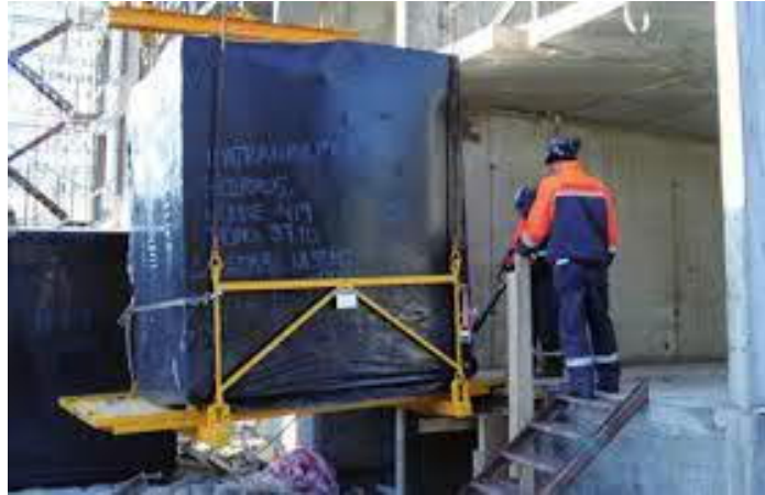
Kuva 25. Kylpyhuone-elementin nostoaputyökalu Imatran Kylpylän laajennusurakassa (Rakennustieto Oy RT 38784, 2016)
