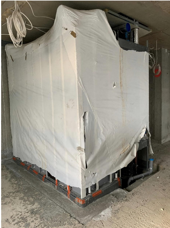
Kuva 17. Kylpyhuone-elementti asennettuna paikalla valettuun välipohjaan
