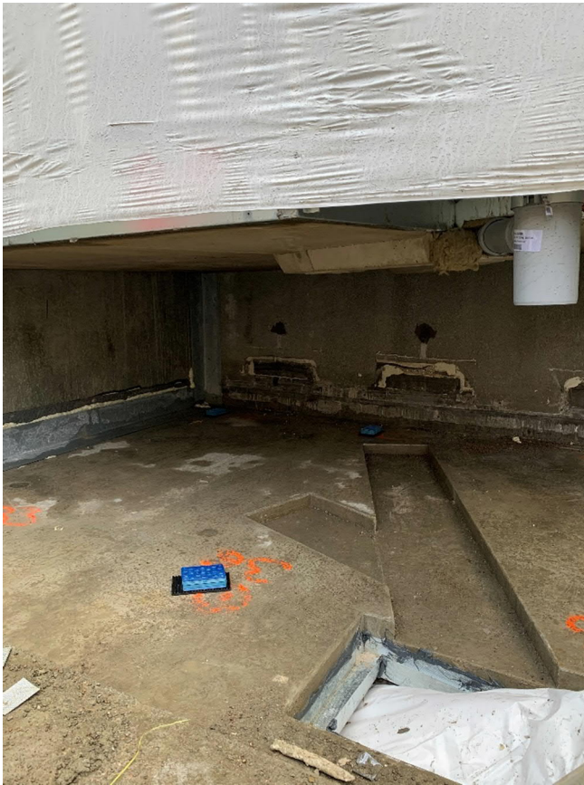
Kuva 14. Kylpyhuone-elementin vaatimat syvennykset kololaatta-asennuksessa
