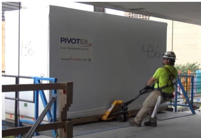
Kuva 23. Kylpyhuone-elementin siirto rakennuksen sisälle (The Weitz Company 2017)
