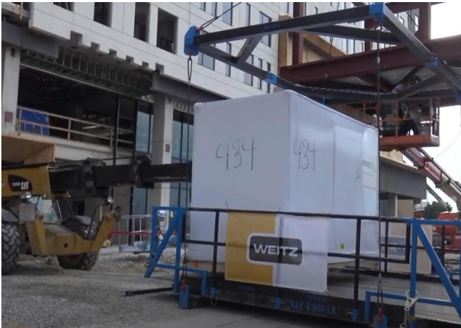
Kuva 21. Kylpyhuone-elementin siirto nostolavalle (The Weitz Company 2017)
