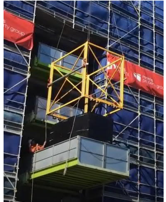
Kuva 27. Rakentamisen aikainen lastaustaso rakennuksen julkisivussa (Project Modular 2019)
