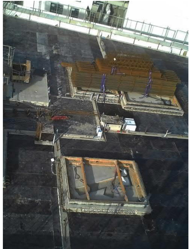
Kuva 15. Esivalmistettu pohjalaatta kylpyhuone-elementin alla paikalla valetun välipohjan kanssa
