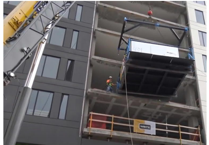
Kuva 22. Kylpyhuone-elementin nosto sijaintikerrokseen (The Weitz Company 2017)
